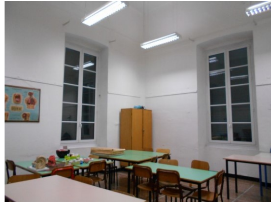
Figura 2.1 - Particolare dei serramenti
