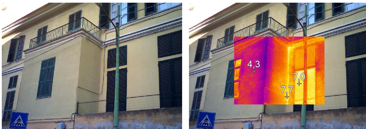
Figura 2.4 – Rilievo termografico dei serramenti
