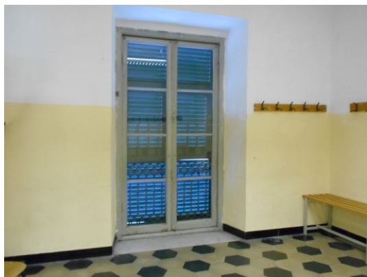
Figura 2.2 - Particolare dei serramenti
