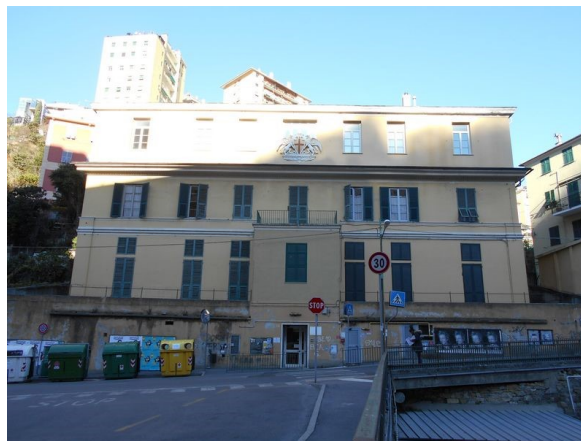
Figura 1.1 - Particolare della facciata principale
